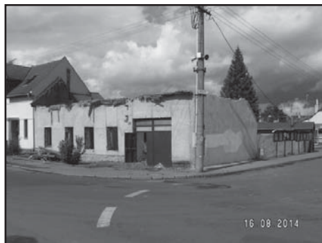
Demolice domu čp. 98
