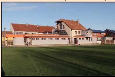
Zateplení víceúčelové budovy TJ sokol
